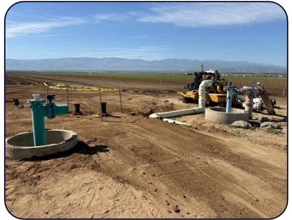
DG25A New Turnout Install
